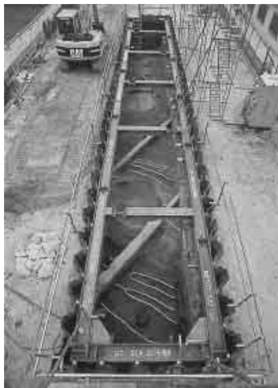
▲榎坂遺跡第7次調査検出遺構(第6次面)
