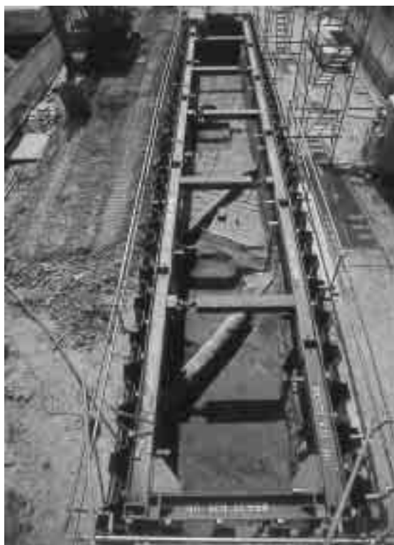
▲榎坂遺跡第7次調査検出遺構(第5次面)
